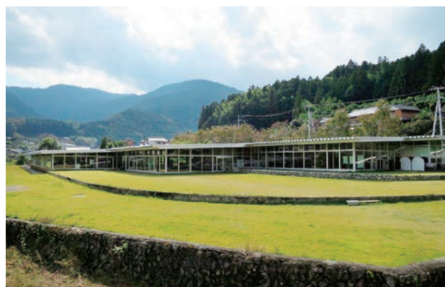
神山まると高専の校舎「OFFICE」外観
