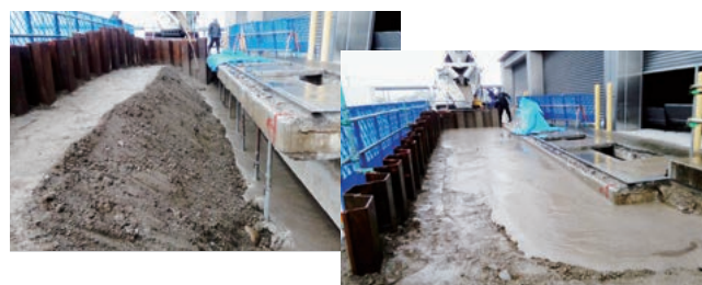
流動化処理土（KFソイル）投入作業（左）と投入後（右）
