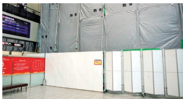
拡張工事が進む国際線旅客ビル(2023年11月10日、IRC撮影)
