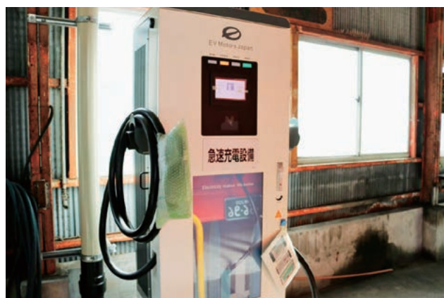
車庫にある急速充電設備 (写真提供:伊予鉄バス)
