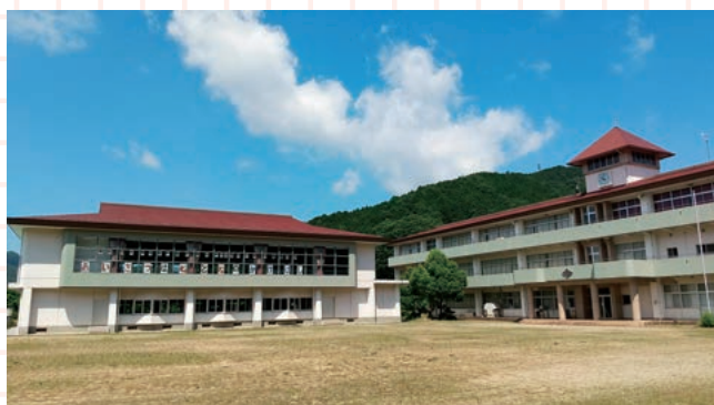
▲廃校の一例である旧菟原小学校
