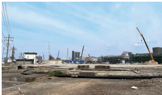
駅高架化・土地区画整理事業が進む松山駅周辺(2022年3月)
