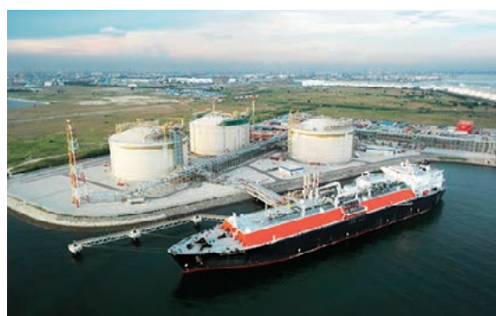
西部・ジュロン地区のLNG貯蔵施設（出典：gCaptain）
