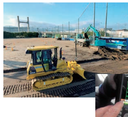
←ICT機器を取り付けたブルドーザー。測量機器と連動した基準高管理で作業時間を削減: (株)愛亀提供
